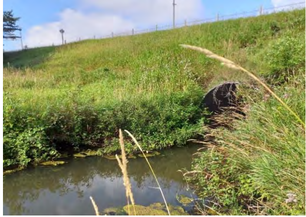
b) Inlet reach (S052) culvert
